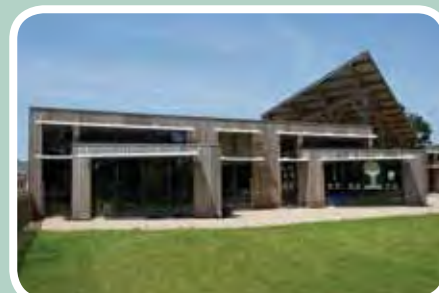
Architecte L'Atelier BELENFANT & DAUBAS Architectes
